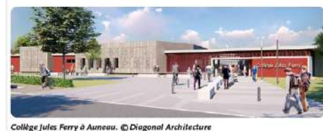
Collège Jules Ferry à Auneau. © Diagonal Architecture
